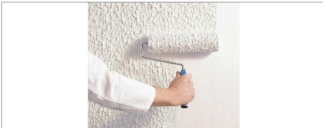
Нанесение Capa-Rollputz с помощью валика.
